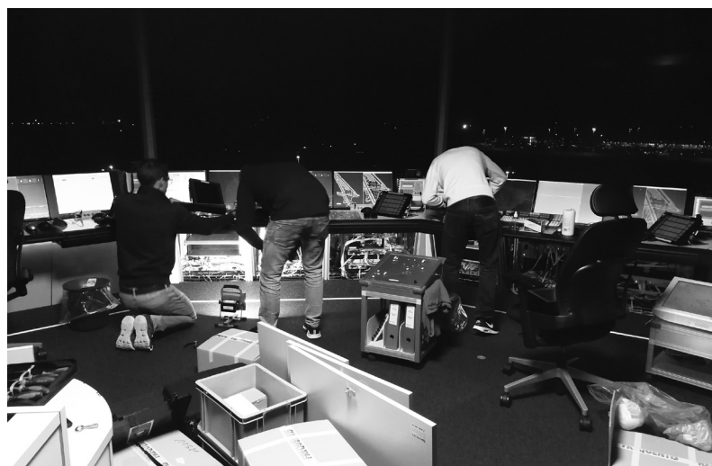
Unterhaltsarbeiten in der Tower-Kanzel.
