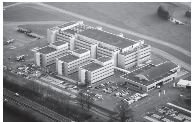
Die Skyguide-Gebäude in Wangen/Dübendorf aus der Vogelperspektive.
